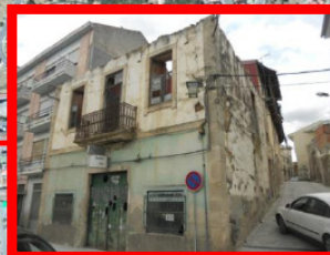
PARU 4 - Reabilitação do edifício na Travessa D. Afonso III para serviços de apoio ao Museu da Oliveira e do Azeite
